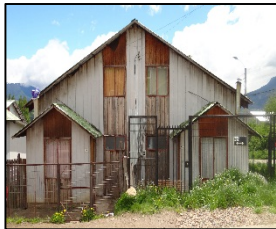
Deficiente aislación térmica en viviendas
